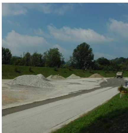
Terreno con rivestimento duro a Balerna
