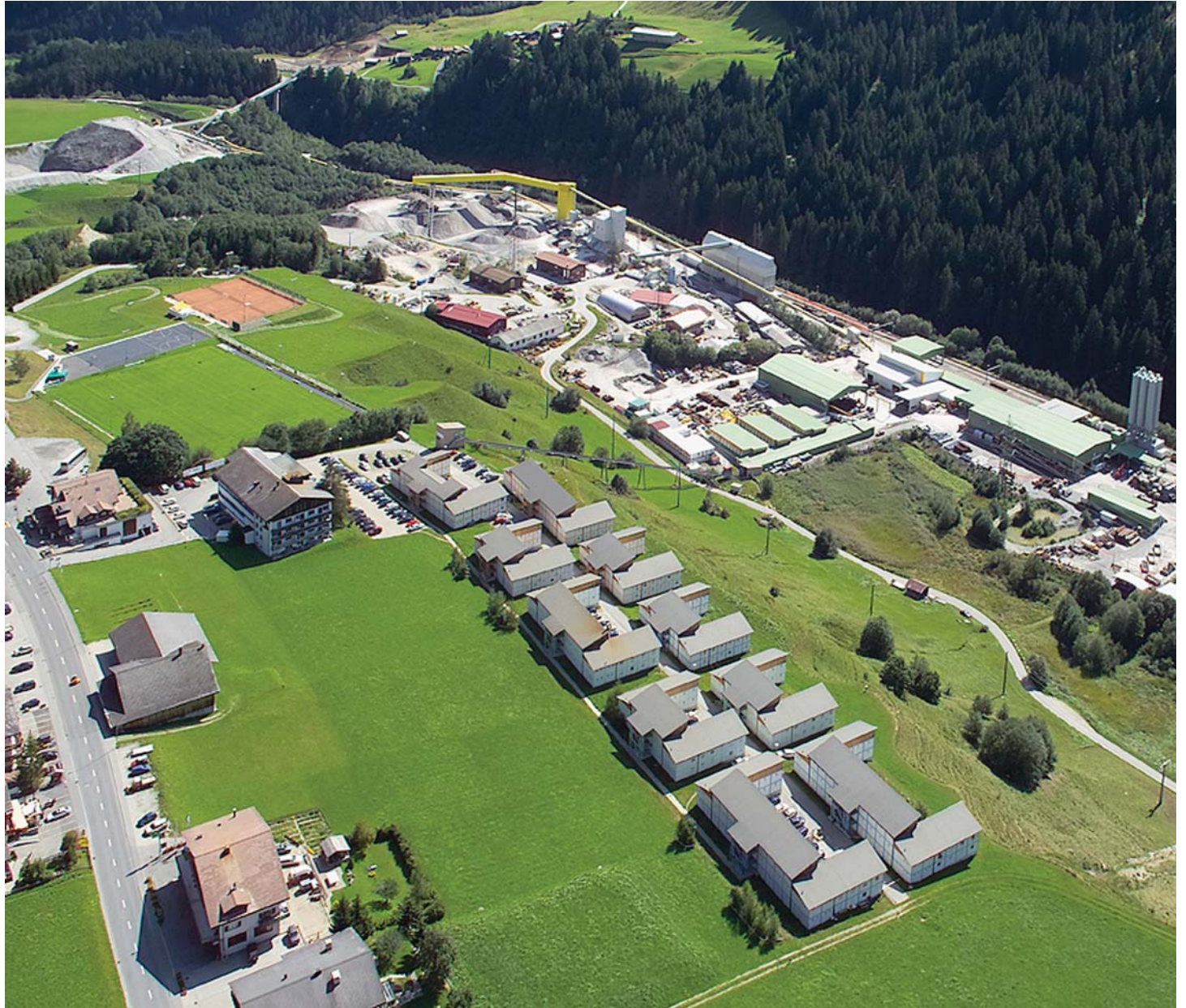
Il cantiere e il villaggio dei minatori di Sedrun - vista aerea (settembre 2009)
