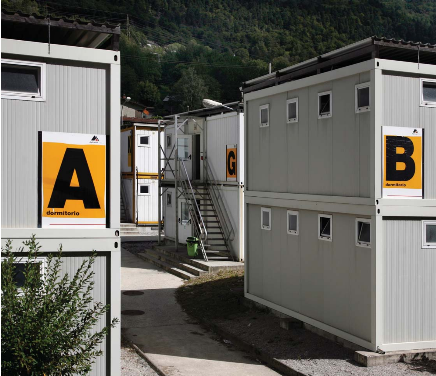
Il quartiere dei dormitori del cantiere di Faido - Polmengo (agosto 2010). Fonte immagini: Lorenza Boschetti
